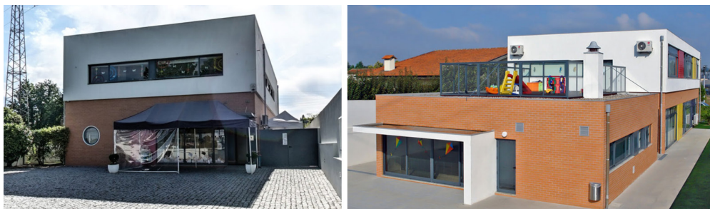
Figura 2 Edifício selecionado como caso de estudo [7]
