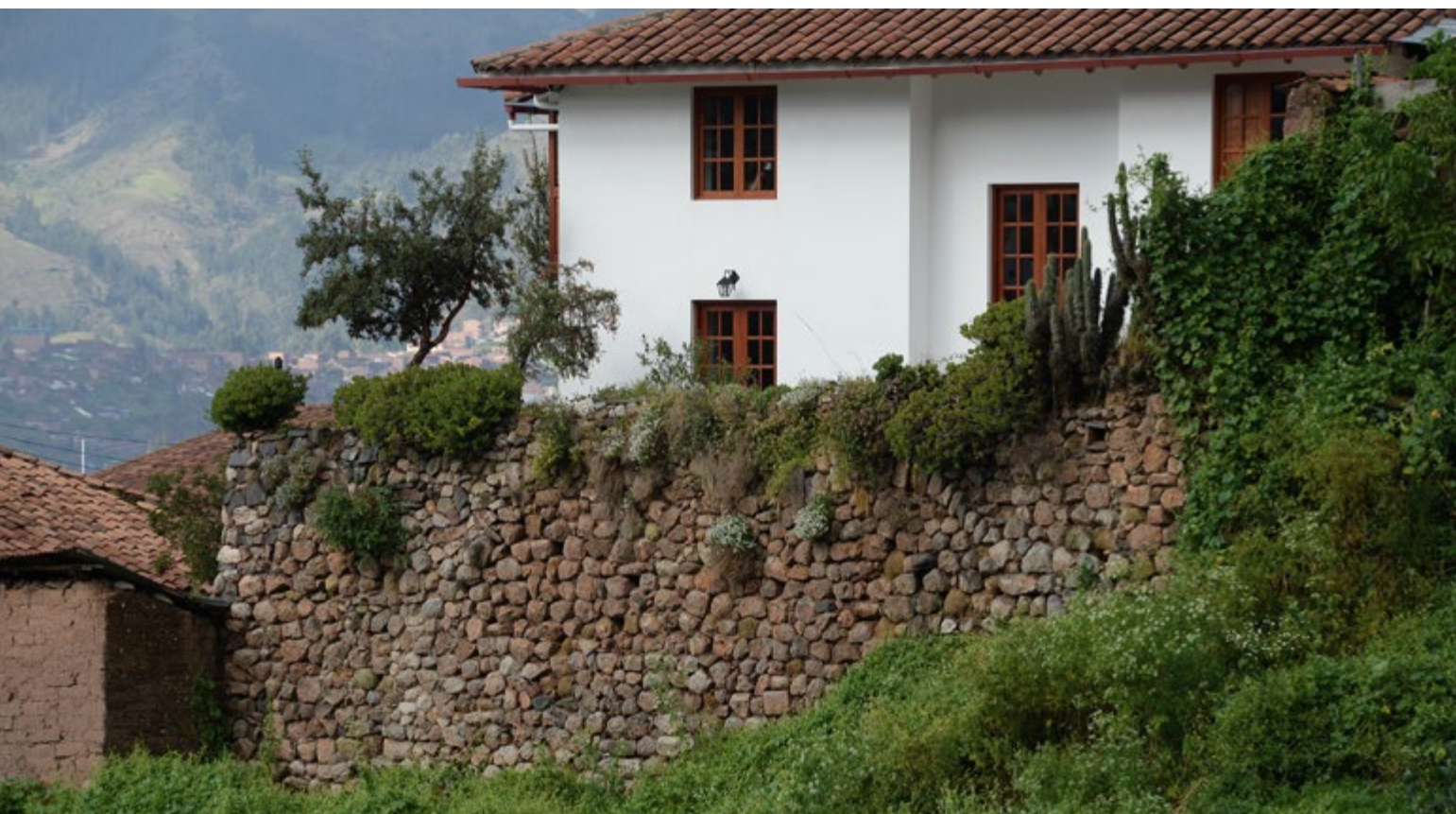
Figura 3.11 Muro de contención de terraza en la zona de Pumacurco (Foto: A. Rifa).
