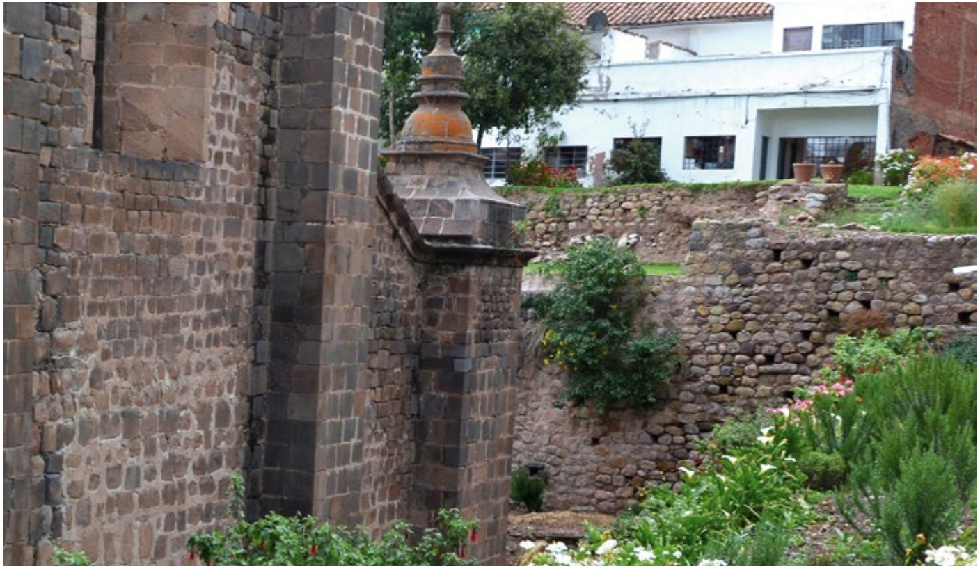
Figura 3.36 Muros de terrazamiento escalonado situados detrás de la Catedral (Foto: R. Mar).
