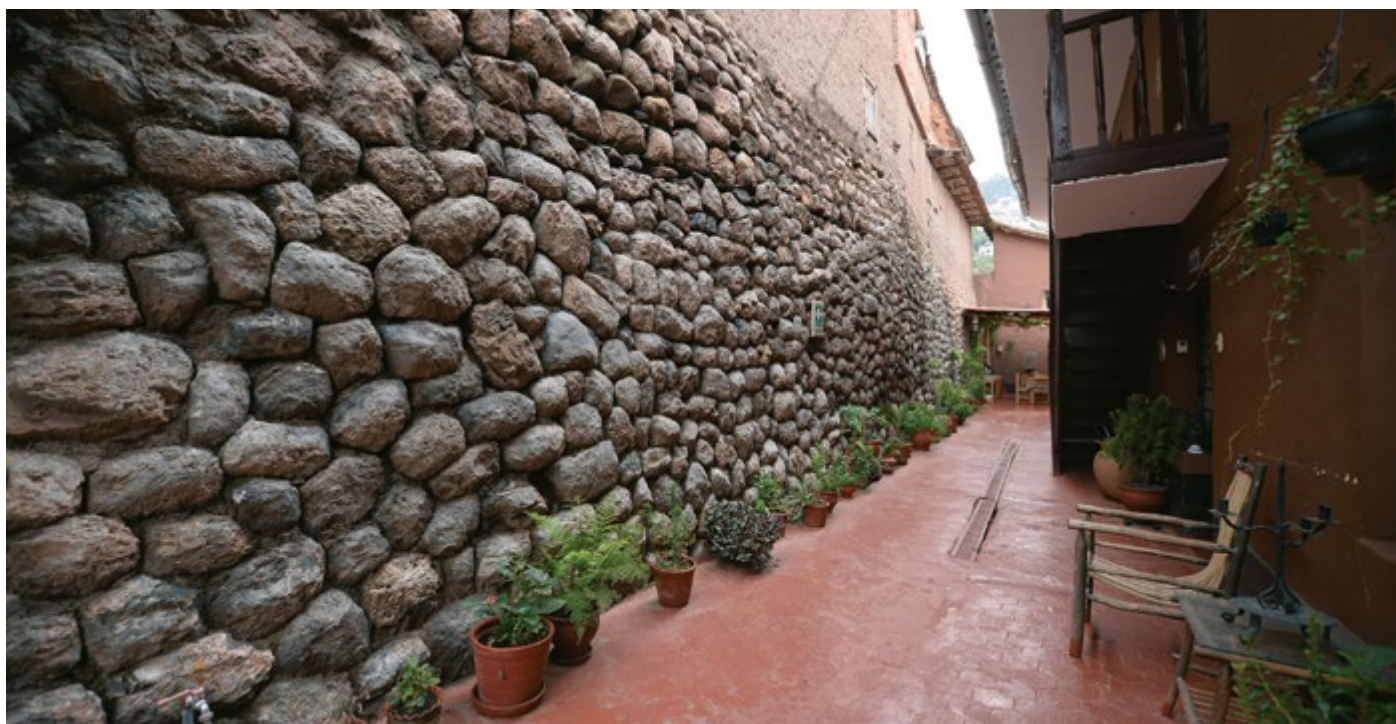
Figura 3.12 (Arriba) Muro de contención en la calle Teqsecocha (Foto A. Rifà).
