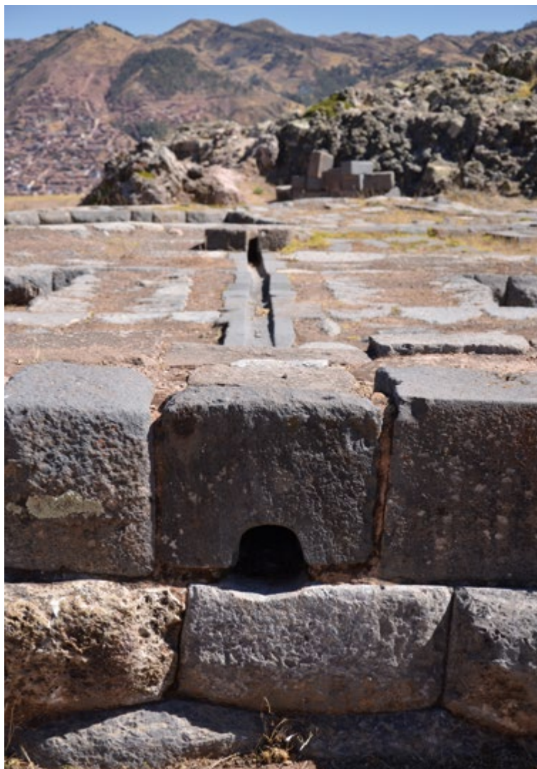
Figura 4.18 Conductos hidráulicos en el torreón circular y en otros sectores de la Gran Plataforma de Saqsaywaman (Fotos: R. Mar/J.A. Beltrán-Caballero).
