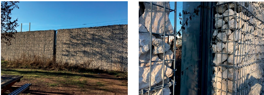
Figura 24 Barreira em pedra ensacada.
