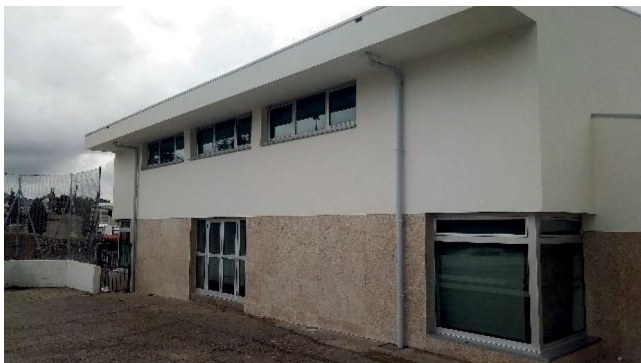
Figura 48 BUILD: Edifício do 1.º Ciclo da Escola das Enguardas após revestimento térmico e sombreamento.
