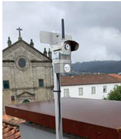
Sensor instalado em Braga
