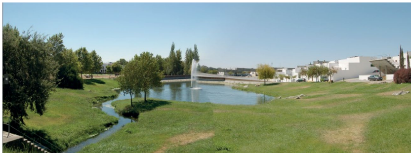
Figura 13 Bairro da Malagueira, em Évora, de Álvaro Siza; fotografia de Eduardo Fernandes.
