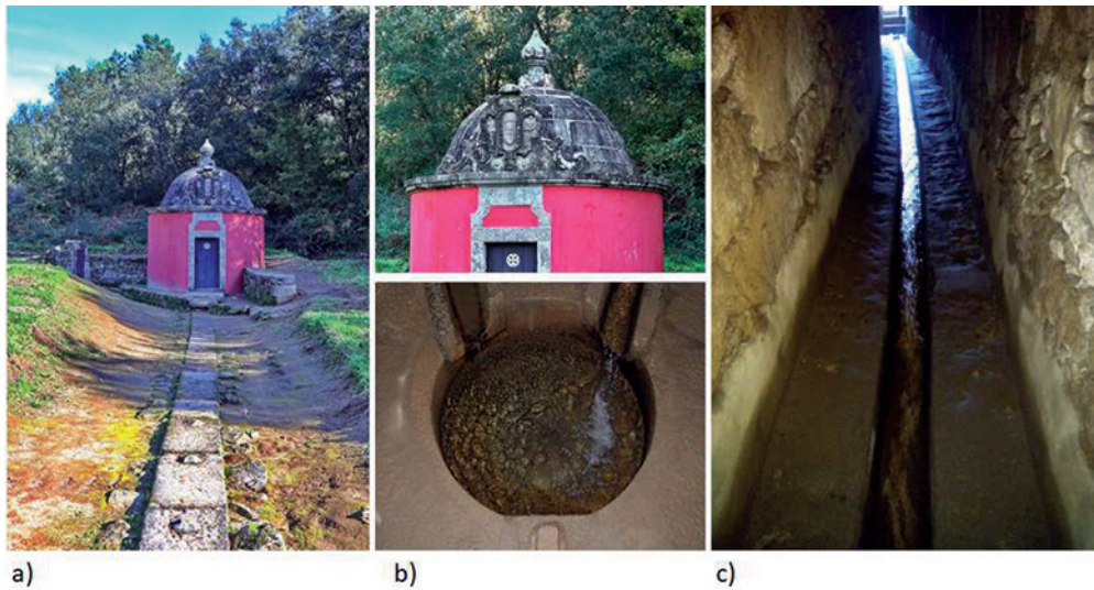
Figura 3.11 Sistema de abastecimento do Vale das Sete Fontes (século XVIII): a) “capela” e aqueduto de pedra e b) exterior e interior duma das “capelas”, com água proveniente de duas galerias, mostrando o sistema de tratamento de água, no que respeita à areação e remoção do ferro e manganês (Antunes & Gonçalves, 2018) e c) Mina subterrânea que liga as nascentes às “capelas”.
